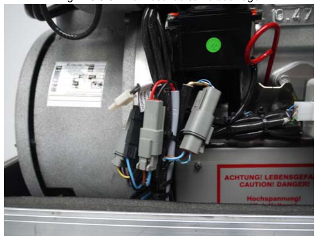
Fig. D.3.6-3: Thermosonde sur le bobinage
